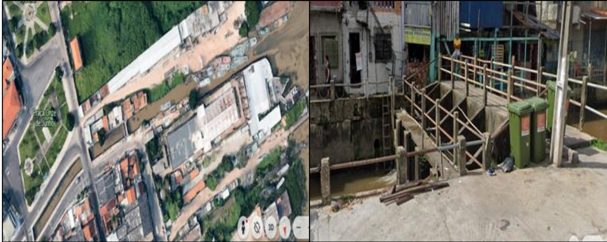
Figura 4. Comportas do Canal da Tamandaré.
