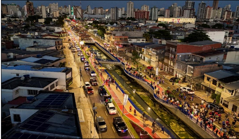
Figura 2. Avenida Tamandaré em Belém-PA depois da implantação do Parque Linear. Nova Tamandaré implantado em Belém-PA.
