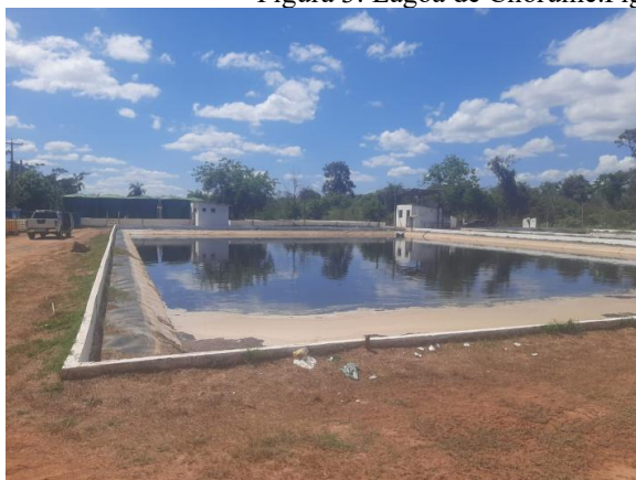
Figura 3: Lagoa de Chorume. Figura 4: Estação de Tratamento de Chorume.
