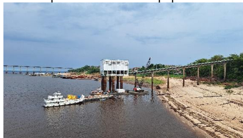
Figura 3 - Vista da captação da ETA II na Ponta do Ismael com suporte de balsa e guindaste para transporte de bombas e equipamentos.
