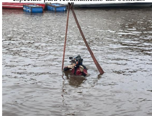
Figura 5 - Uso de mergulhadores e equipamentos especiais para rebaixamento das bombas.
