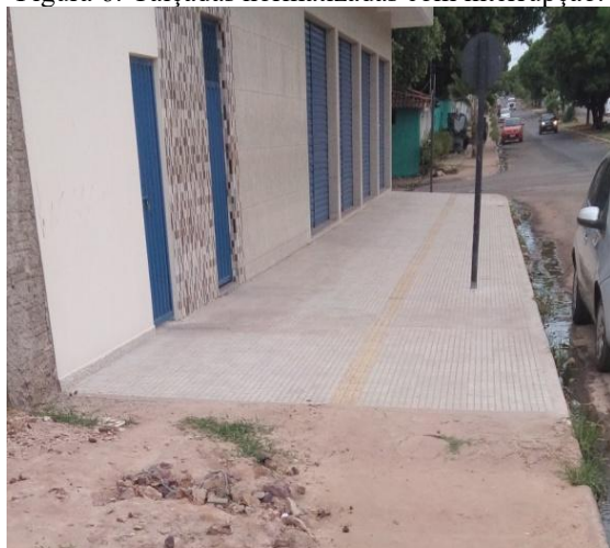
Figura 6: Calçadas normatizadas com interrupção.
